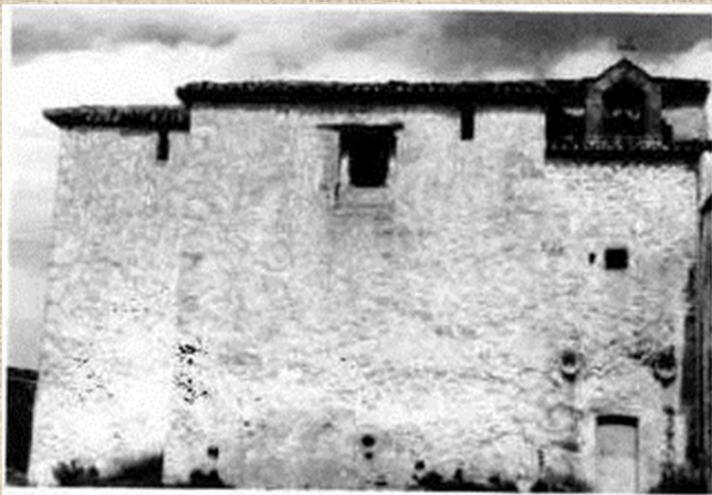
Detalle de la Capilla de la Tercera Orden
