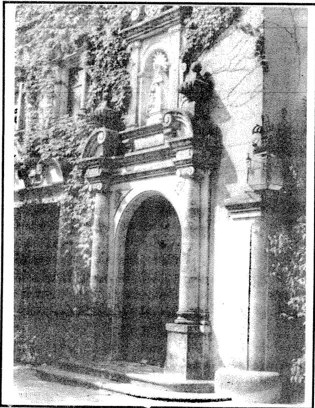
Foto 4.- Detalle de la Capilla
